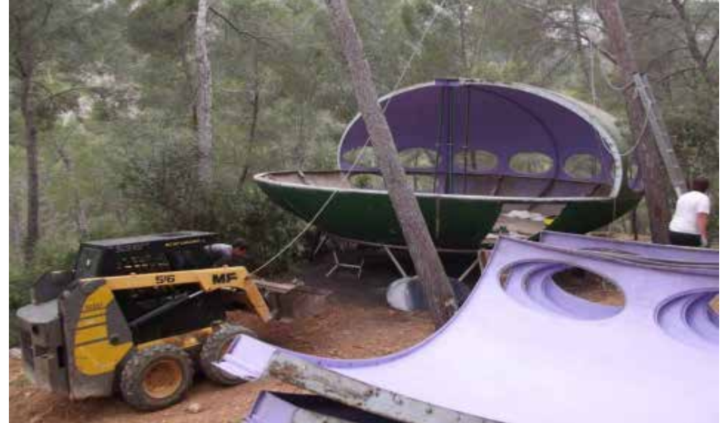
Fotografies del desmantellament de la casa Futuro de Calvià, 2014
